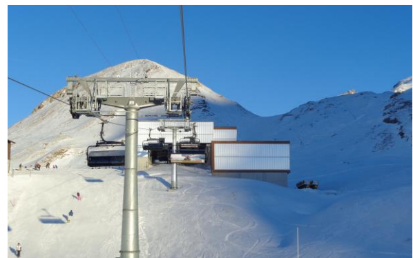
Bergstation Sesselbahn Engstlen
